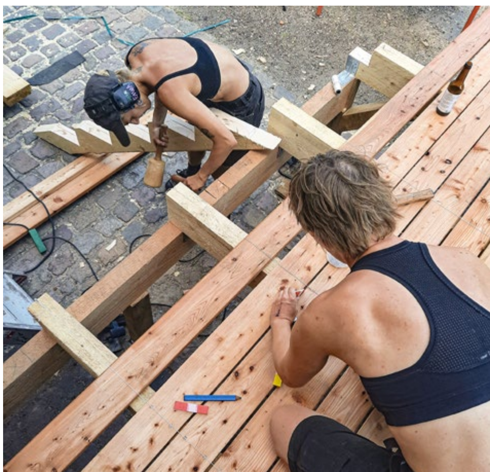
Bygningsnedker Emma Lyhn Støvring stemmer ud til trappens vanger, mens møbelsnedker Laura Klakk mærker op til skruer på terrassedækket.
